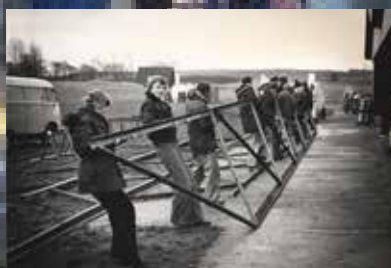
PBP hangaren bliver rejst på Gørlose sidst i halvfjserne ved håndkraft
