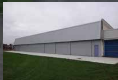
Den nye sydhangar fix og færdig
